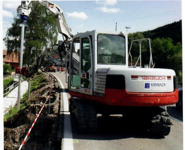
Einbau Schraubfundamente.
