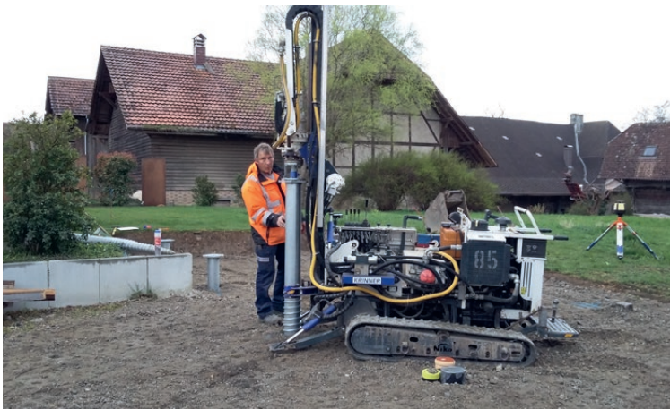
Einbau Schraubfundamente in Ried FR
