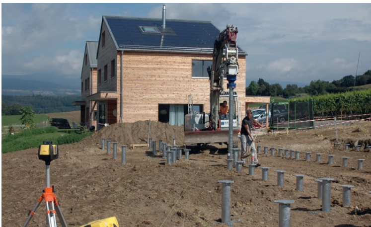
Einbau Schraubfundament für Doppelfamilienhaus in Ins BE
