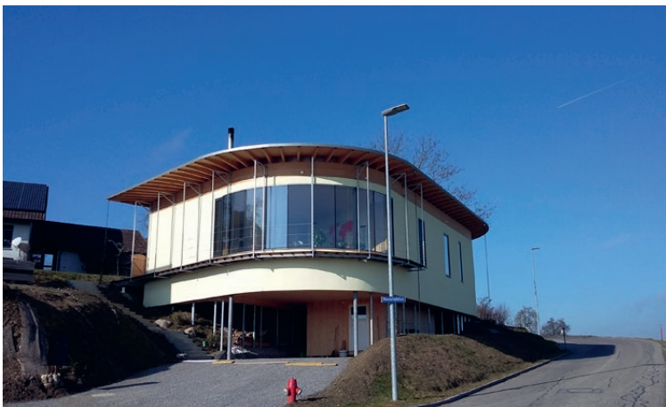
Strohhaus in Geltwil AG, mit Garage
