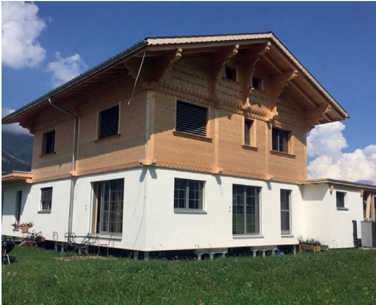
Einfamilienhaus in Diemtigen BE, kurz vor Erstellung einer umlaufenden Terrasse
