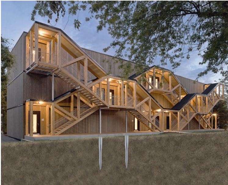
Dreigeschossiges Schulhaus mit Treppenvorbau in Biel BE
