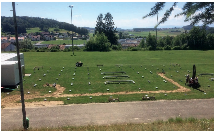
Einbau Schraubfundamente für Erweiterung Schulprovisorium in Courtepin FR
