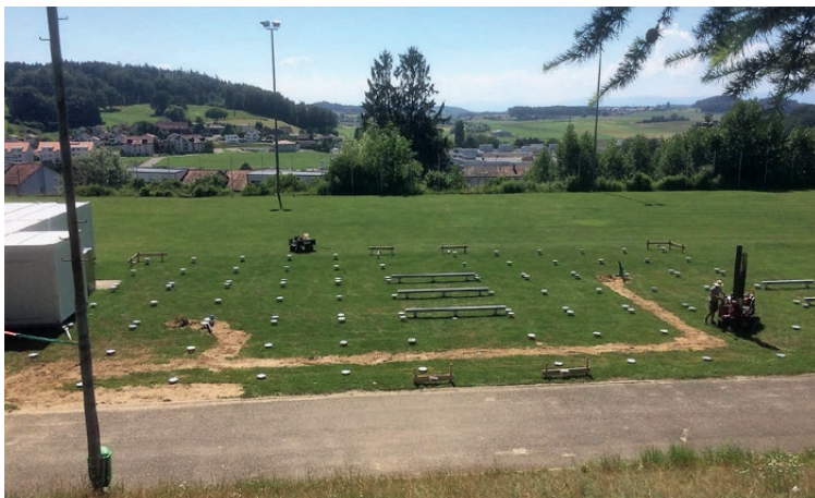
Einbau Schraubfundamente für Containerprovisorium in Courtepin FR
