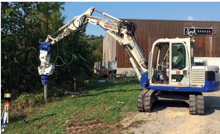
Einbau Schraubfundamente für Büroprovisorium in Herznach AG
