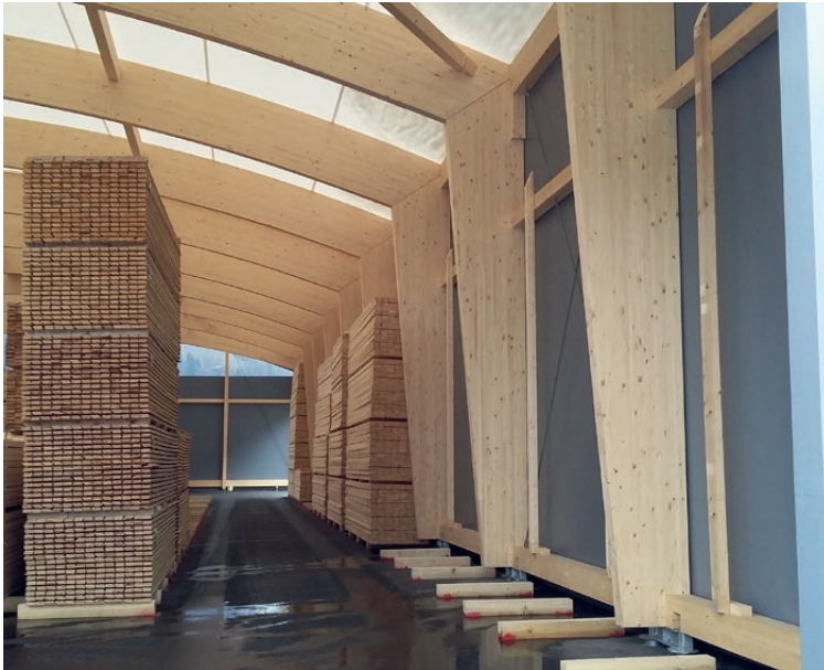
Holzlagerhalle in Erlenbach BE, auf vorgängig erstelltem Asphaltplatz
