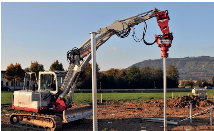
Einbau Schraubfundament mit Bagger
