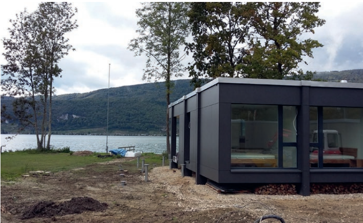
Foundation für Terrasse in Sutz BE
