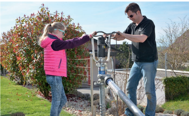
Eigenbau der Schraubfundamente mit Elektromaschine
