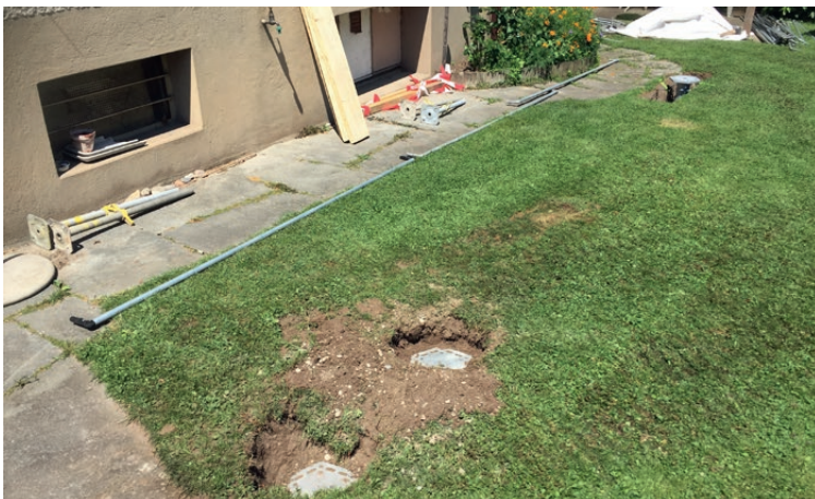
Schraubfundamente für Balkonstützen in Gümligen BE
