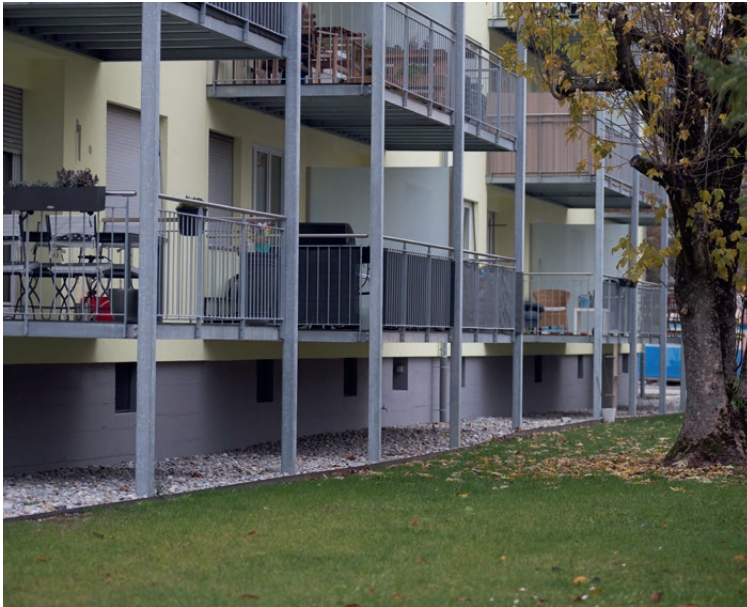
Balkonabstützung in Biel BE
