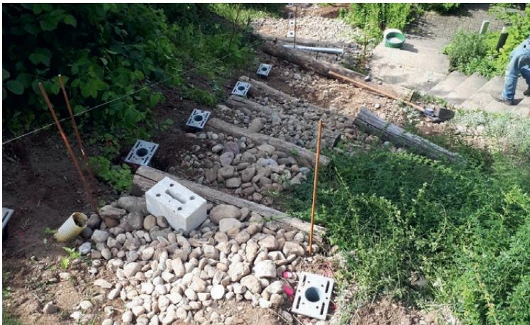
Schraubfundamente für Treppenlift in Grüt ZH
