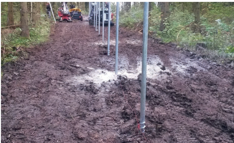
Einbau Schraubfundamente inkl. Zaunpfosten
