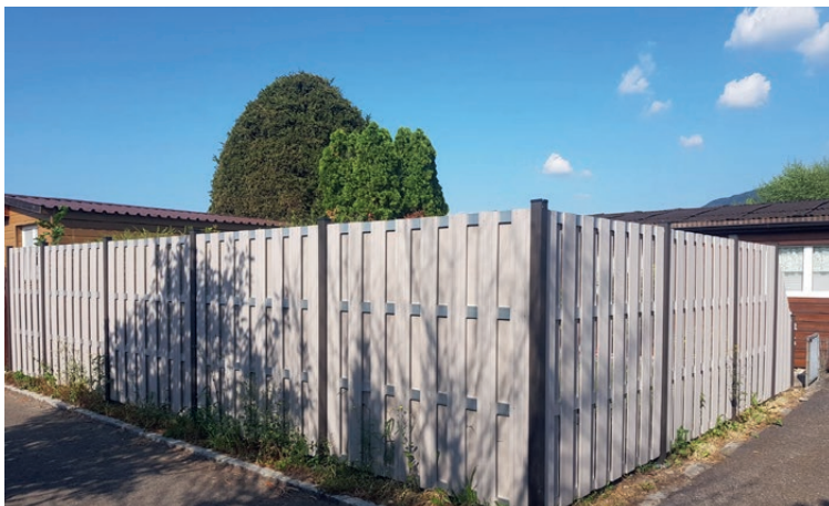
Sichtschutz Campingplatz Sutz BE
