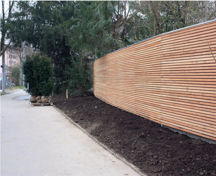
Lärmschutzwand in Tiefenbrunnen ZH
