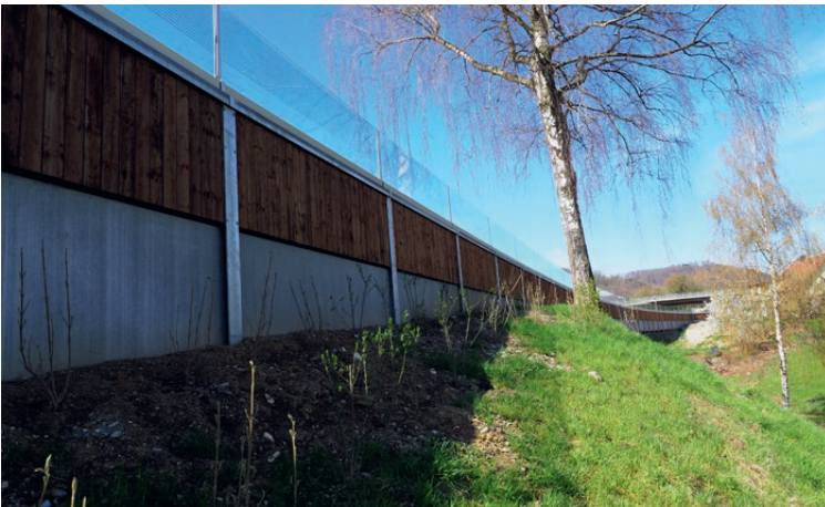
Lärmschutzwand in Rekingen AG
