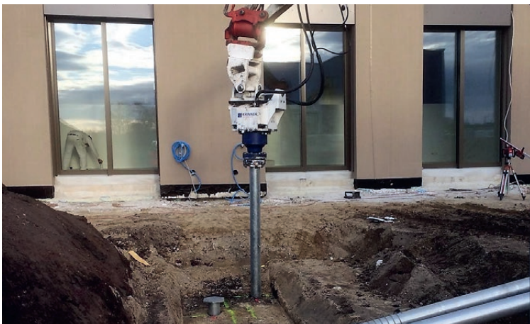
Einbau Schraubfundamente für Betonwand in Muntelier FR
