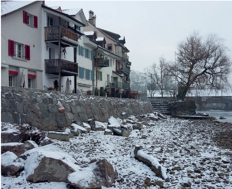
Hochwasserschutzwand in Bremgarten AG
