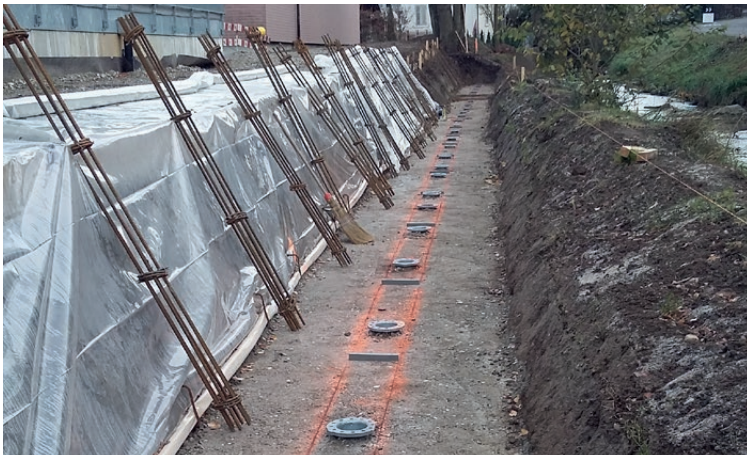
Schraubfundamente für Hochwasserschutzwand in Wohlen AG
