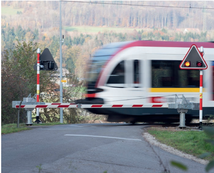
Lichtsignalanlage in Oftringen AG
