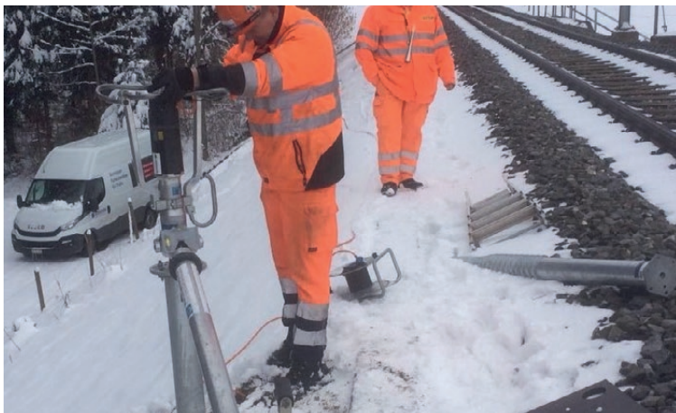
Einbau Schraubfundamente für Kleinmast in Mogelsberg SG
