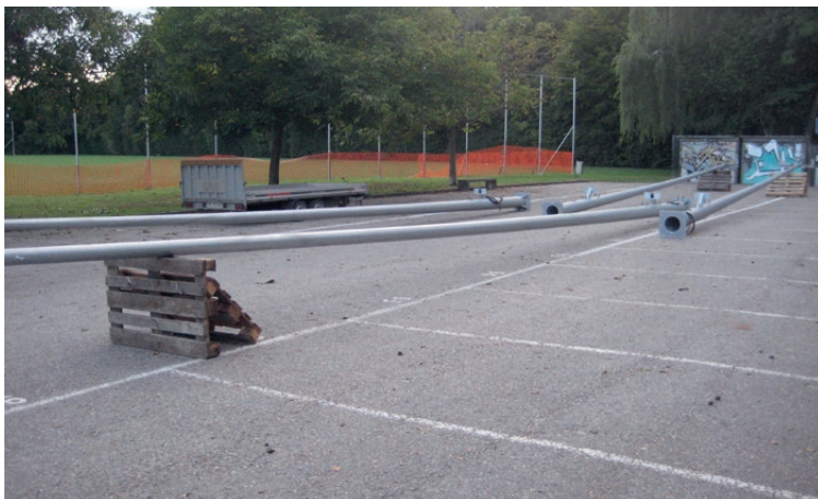
Bereitgestellte Masten für die Montage
