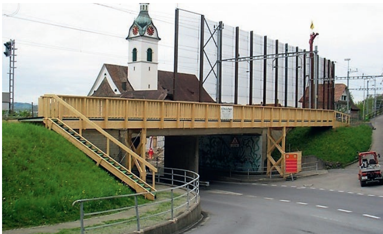
Provisorischer Fussgängersteg in Walchwil ZG
