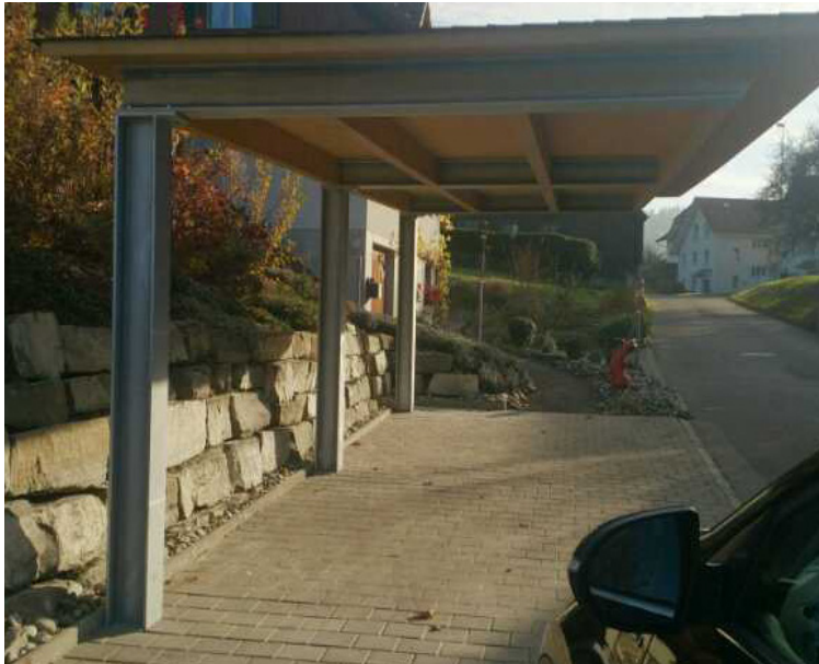
Stahlstützen eines auskragenden Carports in Dürrenroth AG
