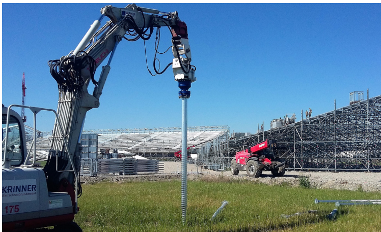
Einbau Schraubfundamente für eidg. Schwingfest in Estavayer FR
