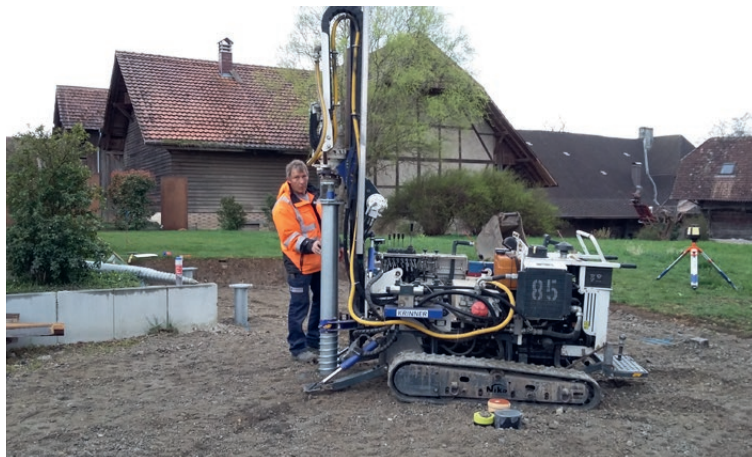
Mis en place de vis de fondation à Ried FR
