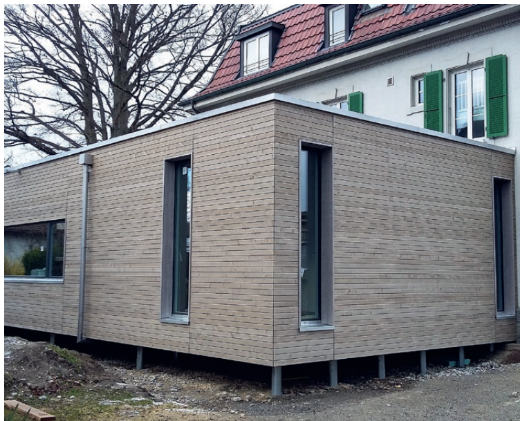
Construction d'une maison d'habitation à Aarberg BE
