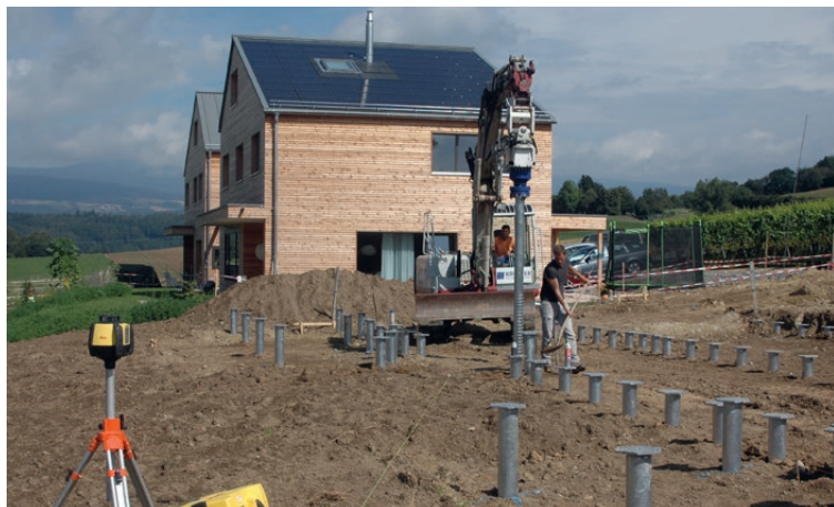
Fondation à vis pour l'installation d'une maison jumelée à Ins BE
