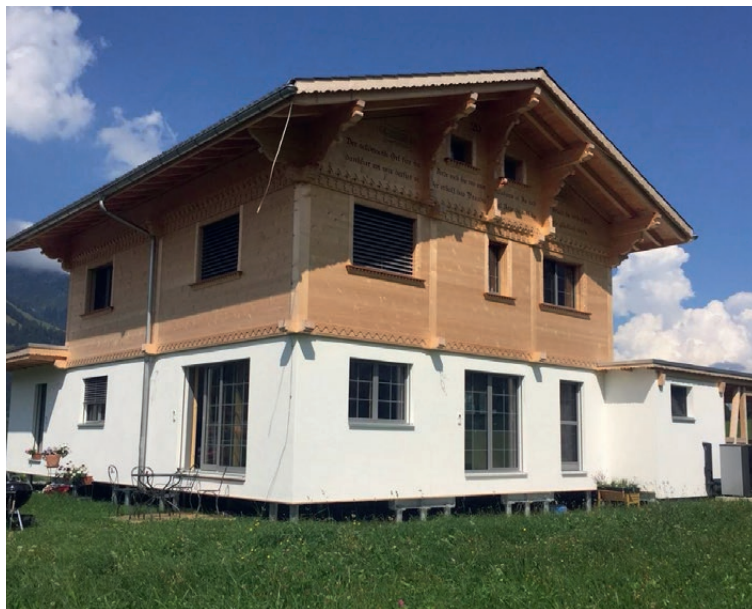
Maison individuelle à Diemtigen BE, peu avant la construction d'une terrasse périphérique
