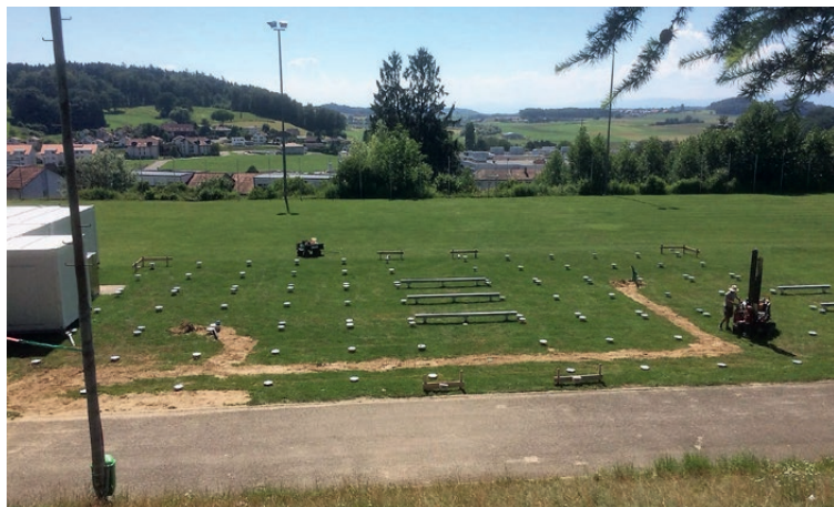
Pose de vis de fondation pour une école primaire à Courtepin FR
