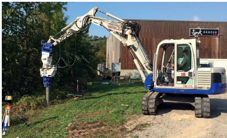
Pose de vis de fondation pour bureaux provisoires à Herznach AG
