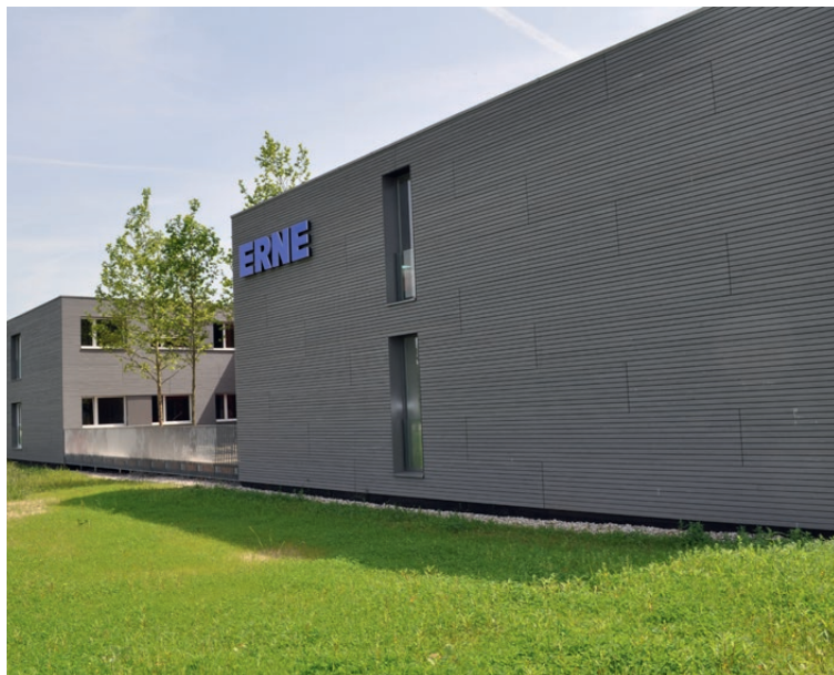
Construction de bureaux modulaires à Stein AG
