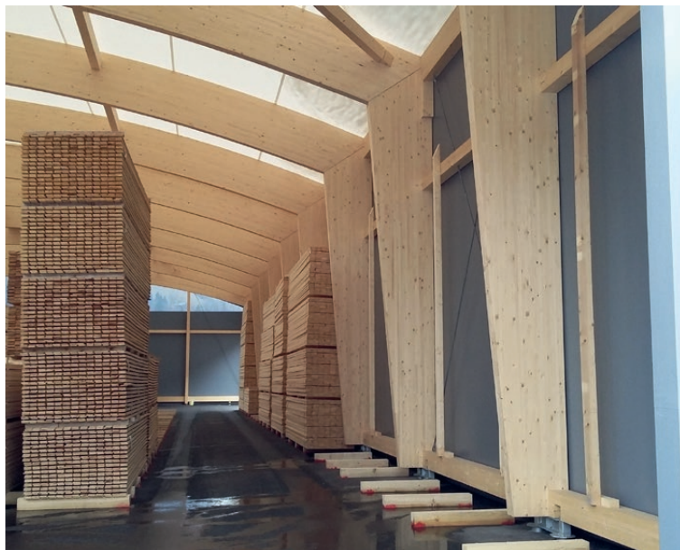
Halle pour stockage de bois Erlenbach BE
