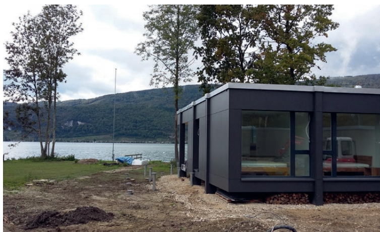
Fondations pour terrasse à Sütz BE
