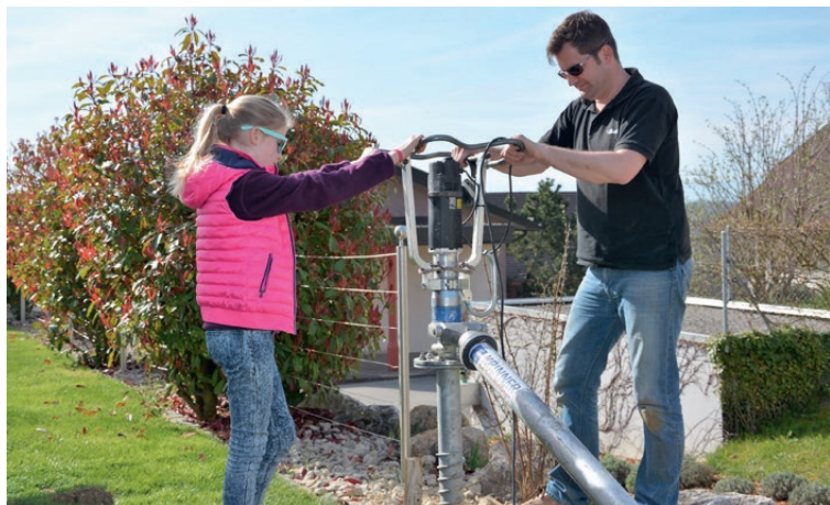
Autoconstruction des fondations à vis avec machine électrique
