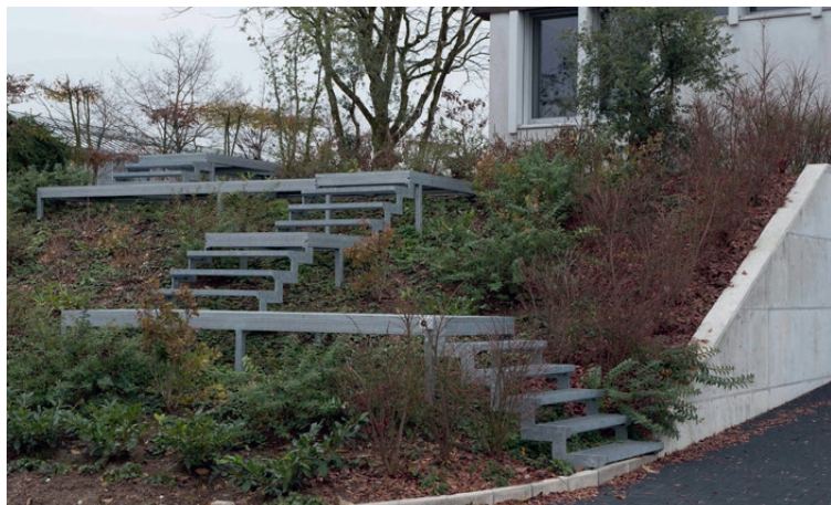
Escaliers à Lyss BE
