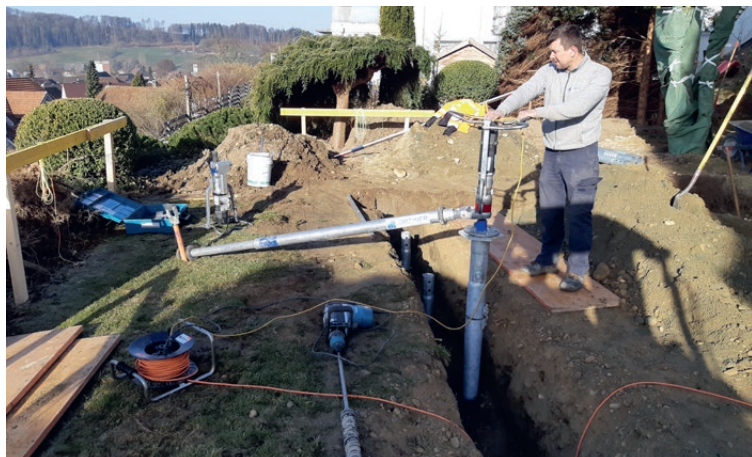
Construction d'une fondation pour le terrassement d'un jardin d'hiver à Madiswil
