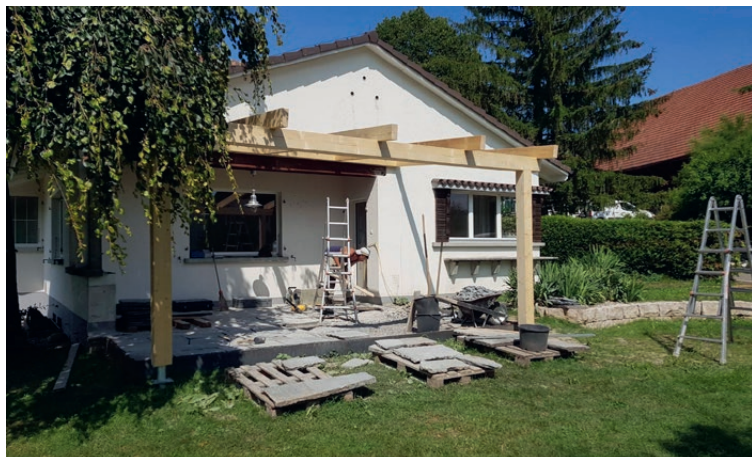
Pergola avec ossature en bois à Sutz BE
