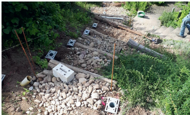
Fondations vissées pour rembarde d'escalier à Grüt ZH
