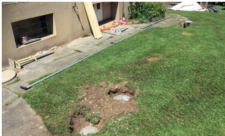
Fondations à visser pour support de balcon à Grüt ZH
