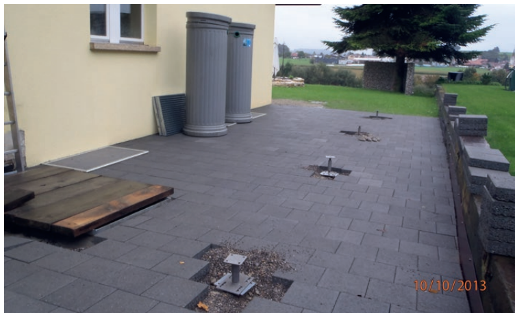
Fondations à visser série F-R avec support de poteau prêtes pour le montage de l'abri auto
