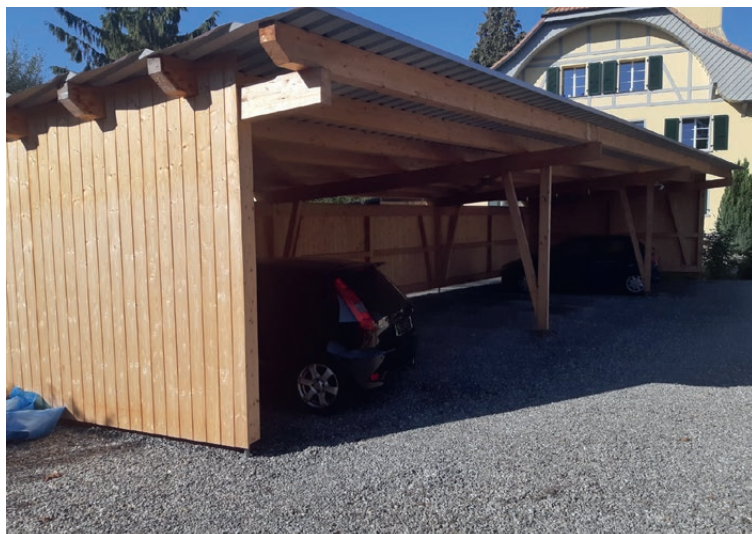
Abri auto en bois multiples sur une cour en gravier à Kappelen BE
