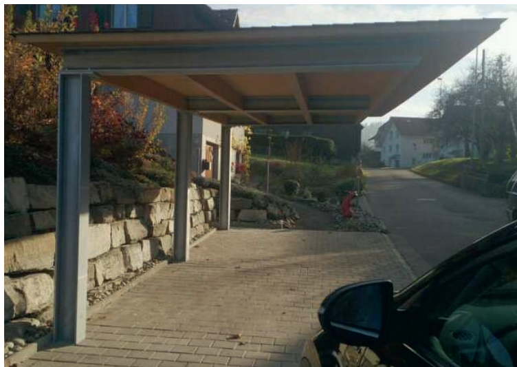
Supports en acier d'un abri auto en porte-à-faux à Dürrenroth AG
