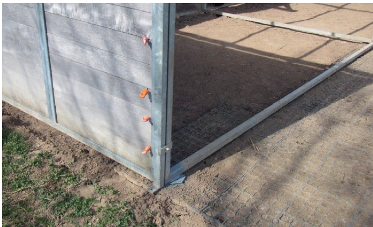
Abris pour véhicules et machines à Walperswil BE
