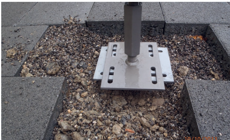
Fondation vissée avec support de poteau pour abri à Jeuss FR
