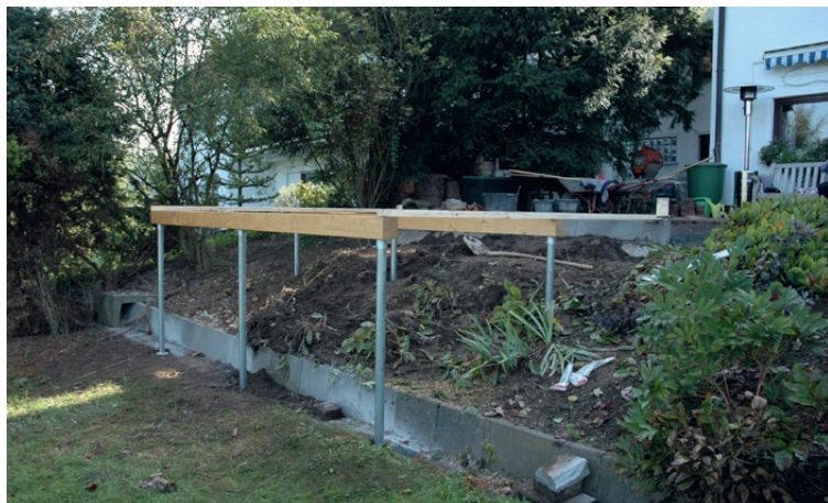
Plateforme pour cabanon de jardin dans une pente
