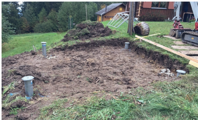
Vis de fondation pour cabanon de jardin à Rüscheegg BE
