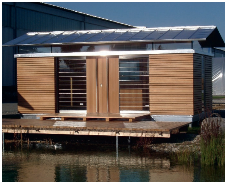
Cabanon de jardin avec terrasse posé sur vis de fondation
