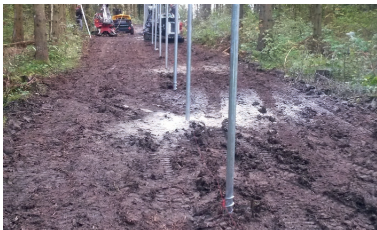
Pose de fondations à vis, poteaux de clôture inclus
