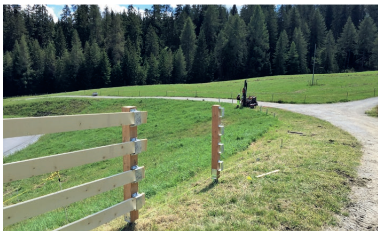
Clôture en bois démontable Lenzereide GR
