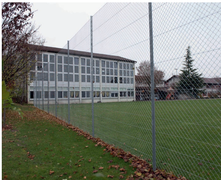
Clôture de stade Kallnach BE
