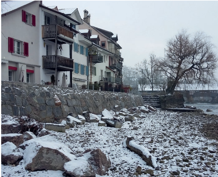
Mur de protection contre les inondations Bremgarten AG
