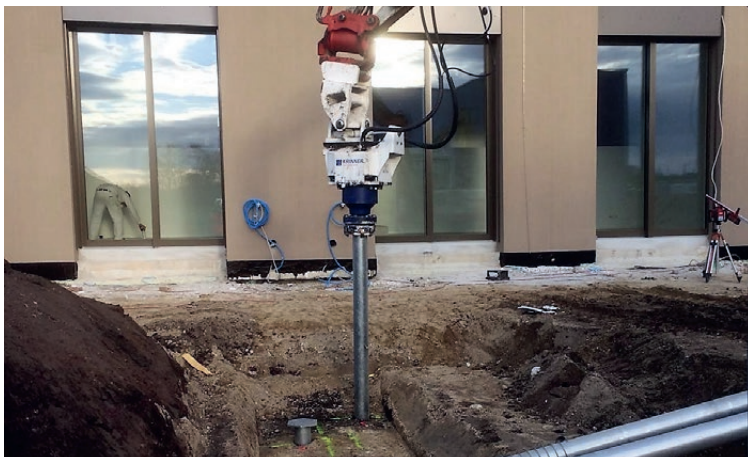
Pose de vis de fondation pour mur en béton Muntelier FR
