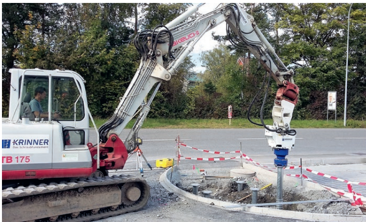
Pose de vis de fondation pour pylône de 10m Buchs SG
