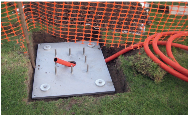
Fondation pour mâts d'éclairage à Nidau BE
