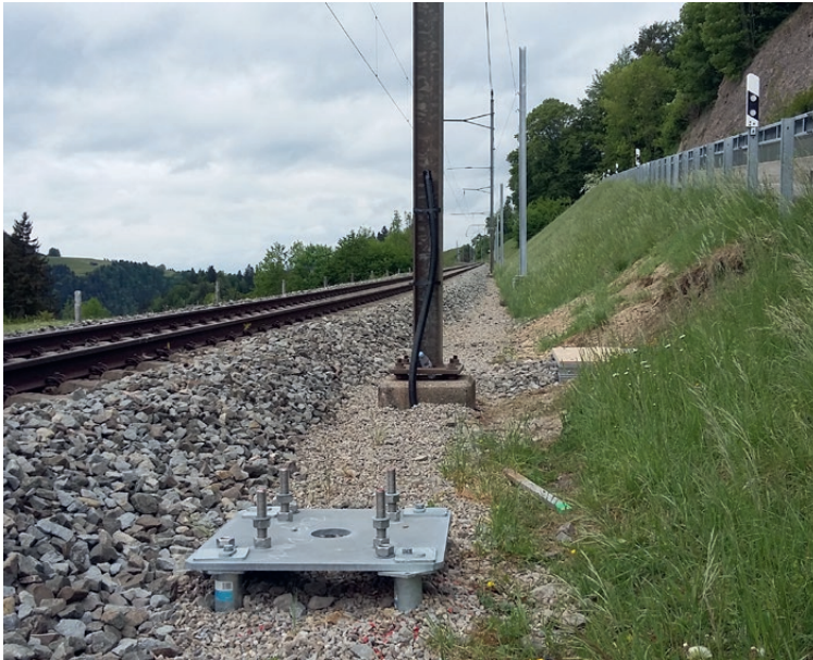
Fondations de mâts pour câbles de communication à Degersheim SG
