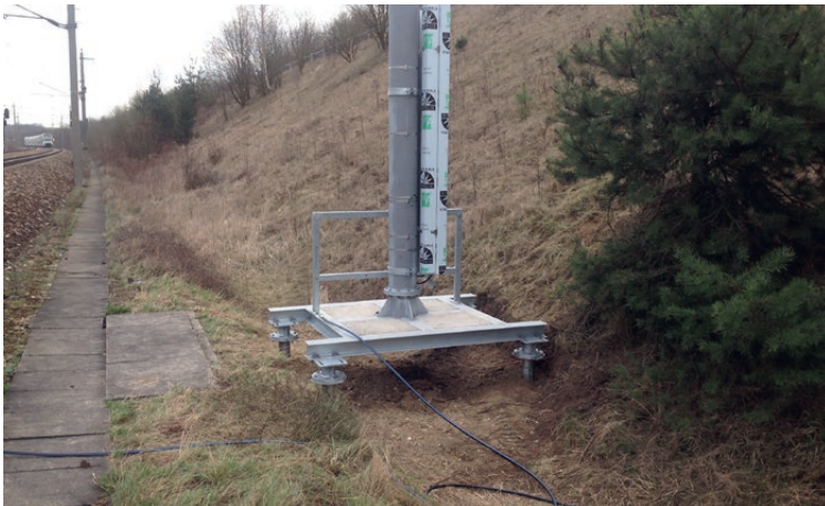
Mât radio sur voie ferrée, avec sous-construction sur 4 fondations à vis
