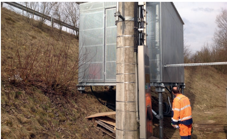
Petit bâtiment de télécommunication sur le remblai d'une ligne de chemin de fer
