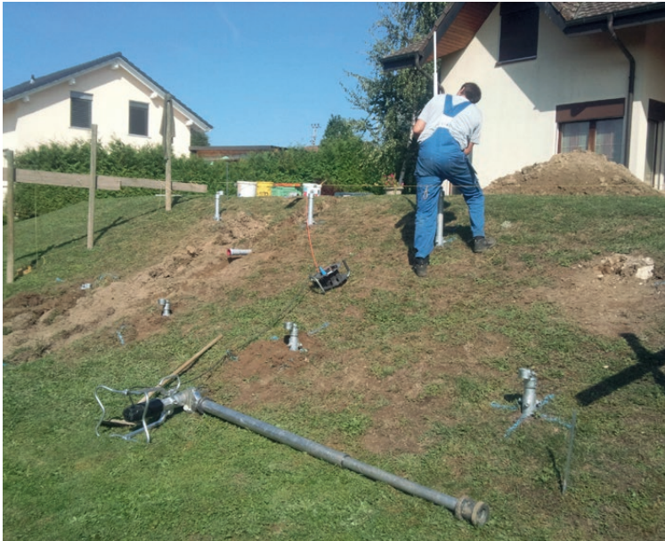
Installation photovoltaïque sur terrain libre montée sur vis de fondation
