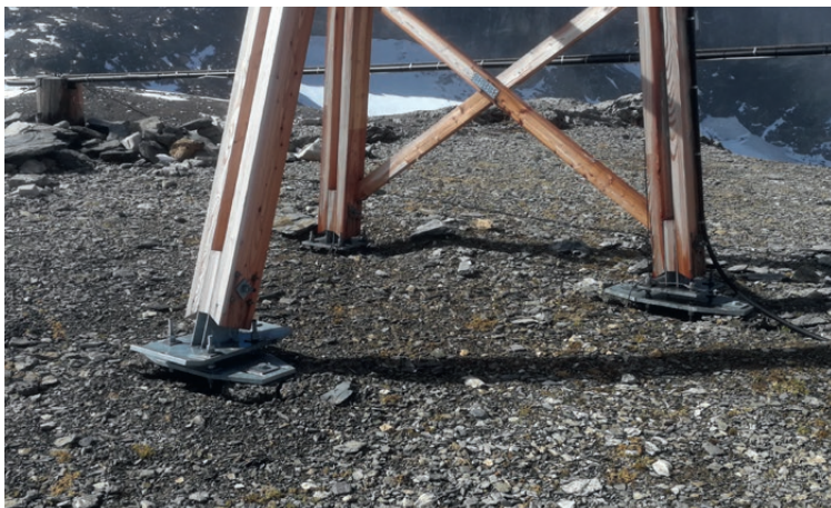
Fondations pour éolienne sur le Lötschenpass BE/VS
