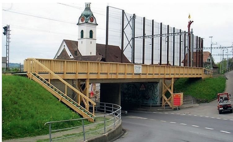
Passerelle piéton temporaire Walchwil ZG
