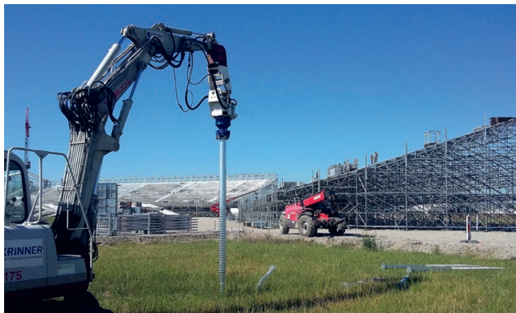
Pose de vis de fondation Fête Fédérale de Lutte Suisse 2016 Estavayer FR
