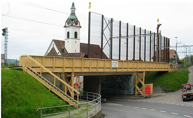
Passerelle provisoire pour piétons à Walchwil ZG
