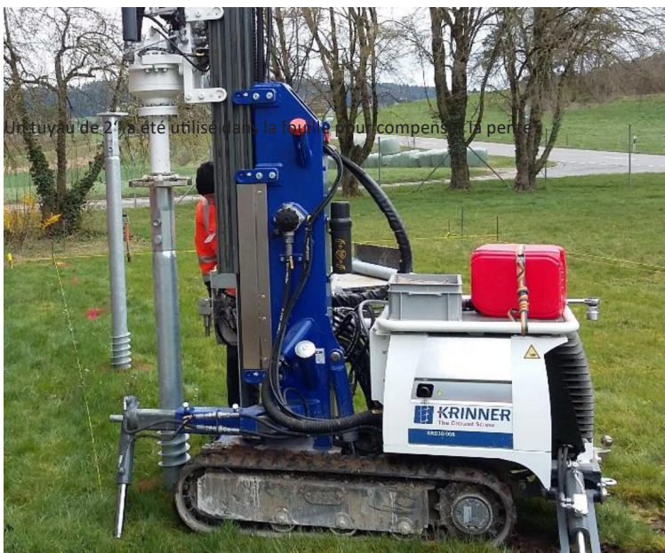
Installation de la fondation vissée avec KR D 30
