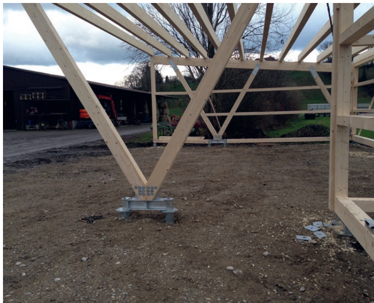
Montage de la construction en bois sur les fondations précises
