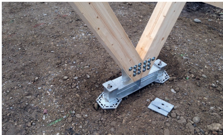
Poutre en acier avec 2 fondations à vis pour supporter la construction en bois
