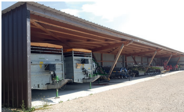
La construction en bois sert d'abri pour les machines et les véhicules.
