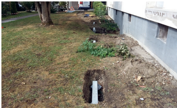
Poutrelles avec perçage intégré pour un montage rapide et précis de l'échafaudage de balcon
