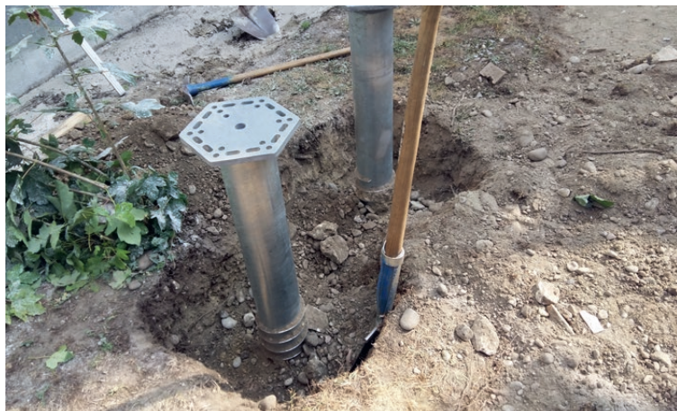
Préparation d'excavation manuelle pour fondations à vis partiellement assemblées
