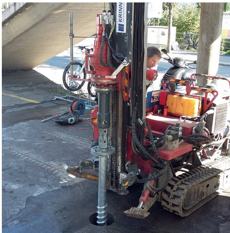
Pose de fondations à vis après carottage dans l'asphalte
