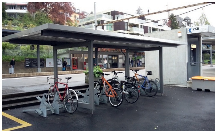
Abri avec adaptateur en acier chromé visible comme raccordement à la fondation
