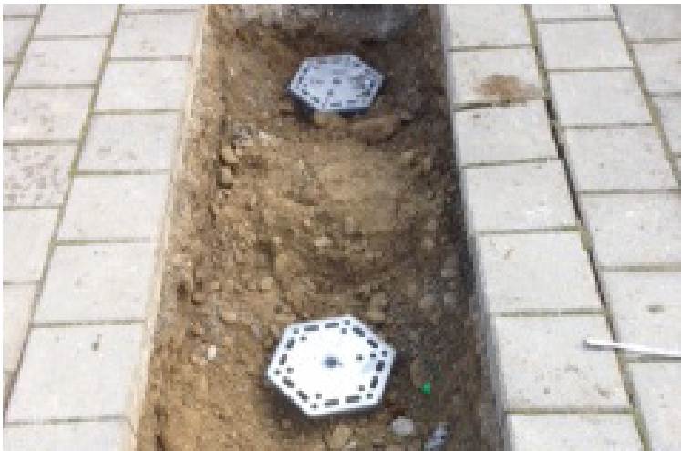
Deux fondations à vis encastrées
