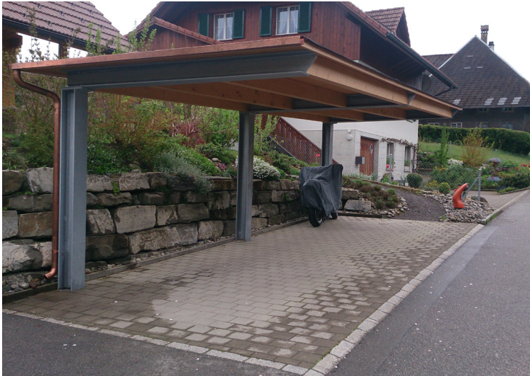
Le toit en porte-à-faux permet de se garer sur le long côté.
