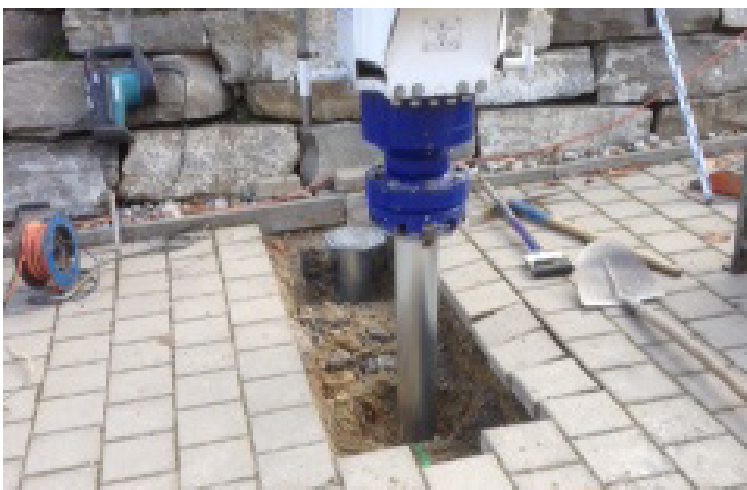
Montage des fondations à vis avec la machine KR B 250
