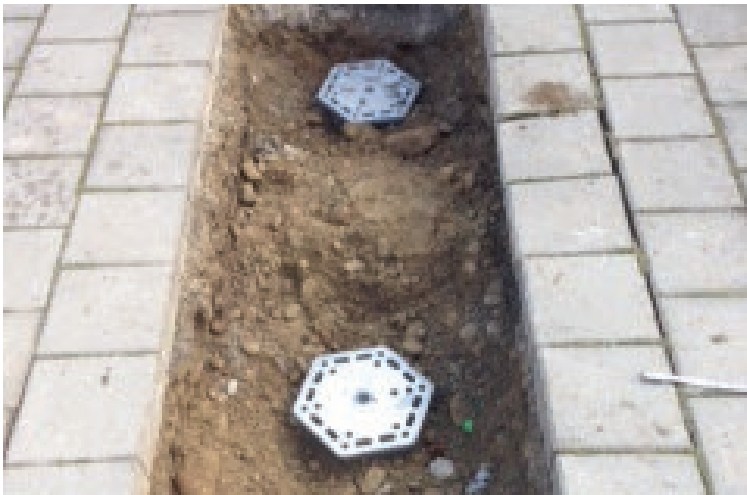
Deux fondations à vis encastrées
