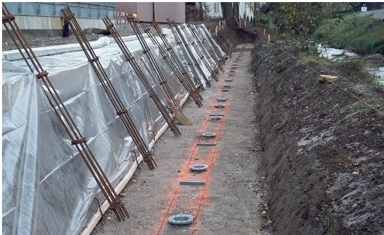
les fondations à vis intégrées avant d'ajuster l'armature
