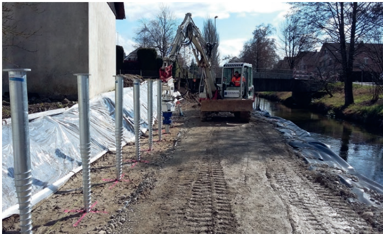
Montage des fondations à vis avec la tête spéciale de la pelle KR B 250
