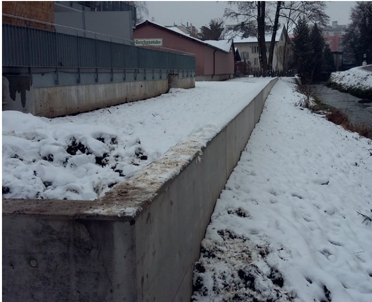
Mur de protection contre les inondations en béton avec fondations vissées intégrées
