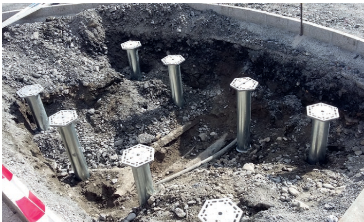
visser les fondations installées entre les lignes existantes
