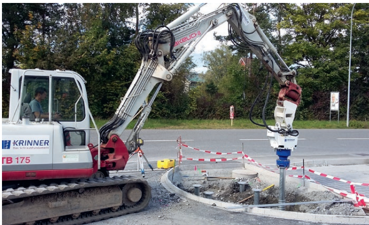
Montage des fondations à vis avec la pelle mécanique KR B 250
