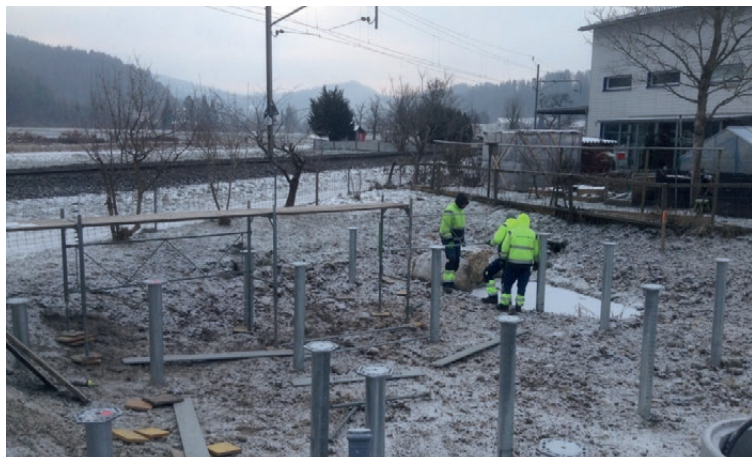
Pose des fondations à vis en temps de gel.
