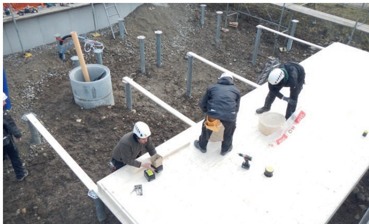
Assemblage d'éléments de plancher sur des fondations vissées
