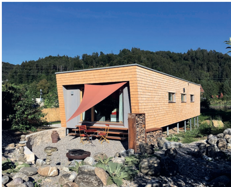
Maison finie avec compensation de pente bien visible
