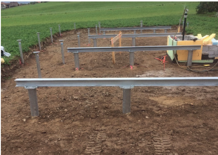
Profils en acier dans la construction, fondations de terrasses comme support direct pour les poutres en bois
