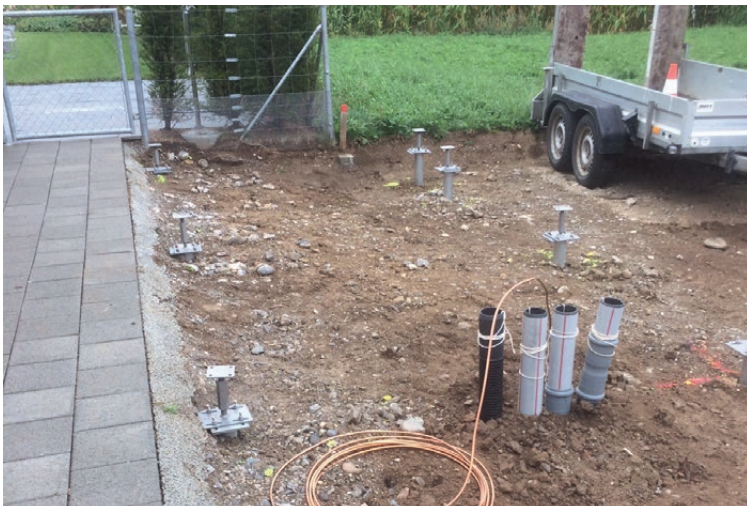
Pour les supports en bois des vis KSF F-R et des supports poteaux ont été installés.
