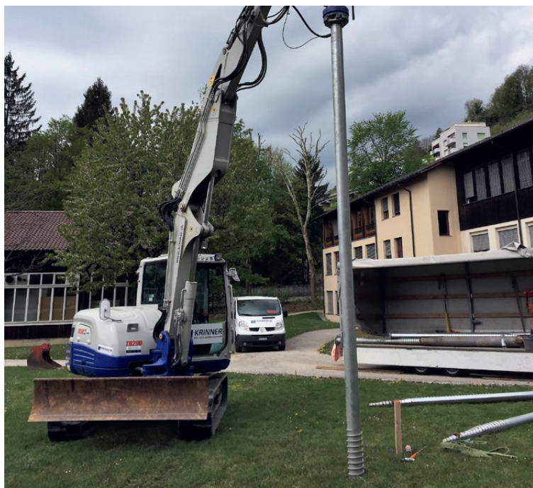
Pose des fondations de 6,5 m de long avec fixation par pelle mécanique.
